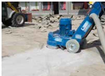
Untergrundvorbereitung z. B. Schleifen oder Kugelstrahlen
