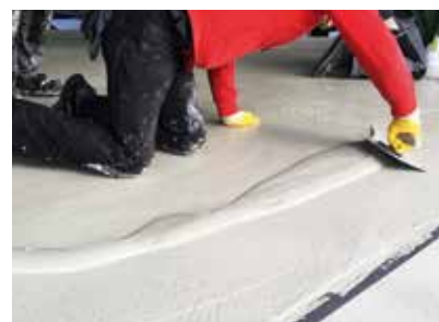
Auswahl von 5 Nutzschiichten, z. B. Strukturbelag Wecryl 419
