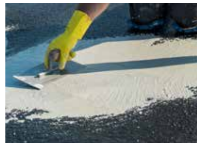
Reprofilieren Auffüllen mit z. B. Betoninstandsetzungsmörtel Wecryl 885
