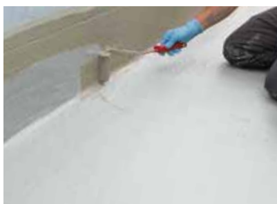
Schutz- und Nutzebene Detailanschlüsse mit Wecryl 488 versiegeln
