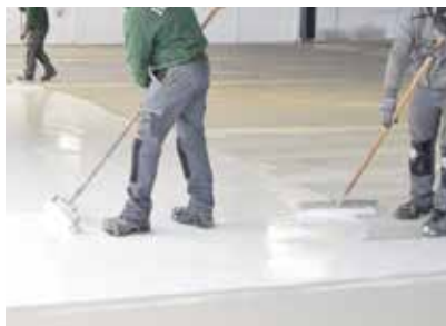
Grundierungsebene auf den Untergrund abgestimmte Grundierung auftragen, ggf. Untergrundverfestiger Wecryl 821 verwenden
