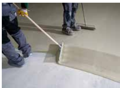
...oder ohne Vlieseinlage, dabei mit Zahngummirakel aufgezogen und mit Stachelroller entlüftet
