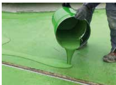
Reprofilieren Kratz- und Ausgleichspachtelung bedarfsweise mit Wecryl 123 K
