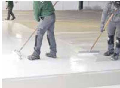
Grundierebene auf den Untergrund abgestimmte Grundierung auftragen
