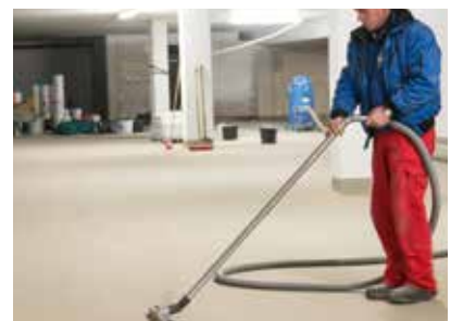
Nach Aushärtung überschüssigen Quarzsand abkehren bzw. absaugen
