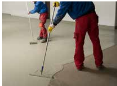
Aufbringen der Kopfversiegelung in der Fläche
