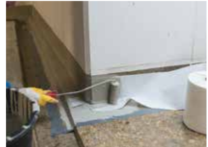
Abdichtungsebene Vliesarmiertes Abdichten von Details: Harz vorlegen – Vlies einarbeiten – mit Harz sättigen
