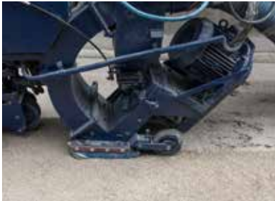
Untergrundvorbereitung z. B. Kugelstrahlen
