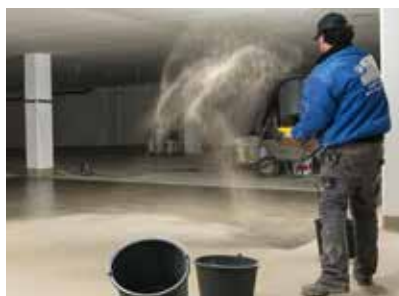
Abstreuen der frischen Einstreulage mit Quarzsand 0,7 - 1,2 mm im Überschuss
