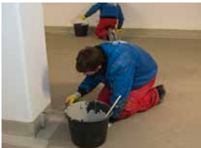
Versiegeln der Detailabdichtungen
