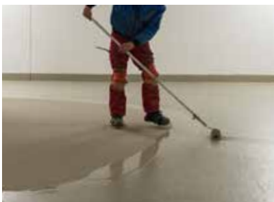
Schutz- und Nutzebene Vorlegen der Einstreulage
