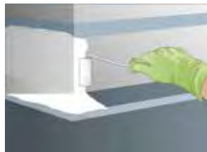
Passende Grundierung auftragen
