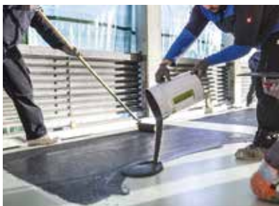
Strukturbelag Wecryl 410 auf den Untergrund auftragen
