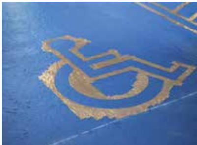
Versiegelung zu markierenden Bereich sauber abkleben
