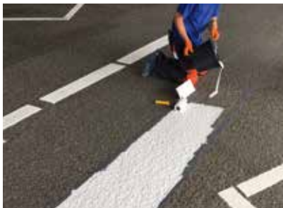
Rollbeschichtung Wecryl 420 auf den Untergrund auftragen
