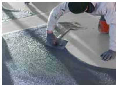
mit Glättkelle verteilen
