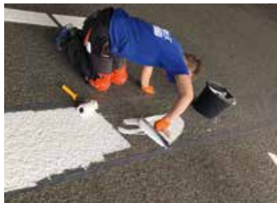
mit Glättkelle verteilen
