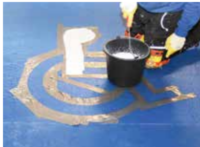
Wecryl 288 auf den Untergrund auftragen
