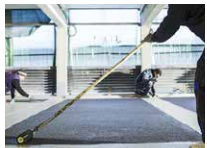
bei Bedarf mit Strukturwalze nachrollen
