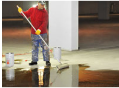
Grundierebene auf den Untergrund abgestimmte Grundierung auftragen
