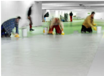
Schutz- und Nutzebene Auftragen des mechanisch hoch beständigen Strukturbelags
