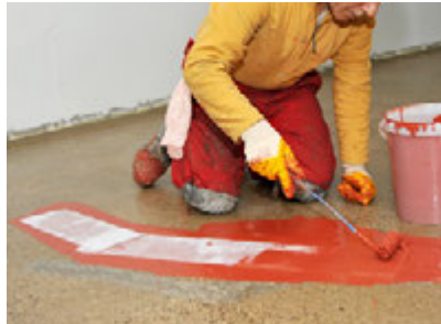
Vliesarmiertes Abdichten von Details wie Risse nach den gleichen drei Arbeitsschritten
