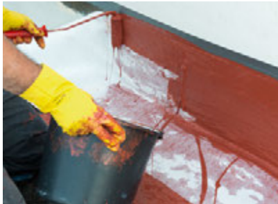
Abdichtungsebene Abdichten von Details wie Wandaufkantungen: Harz vorlegen - Vlies einarbeiten - mit Harz sättigen
