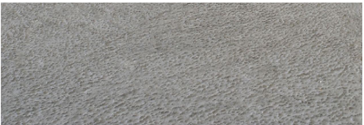
Strukturbelag mit Glättspachtel aufgebracht und anschließend abgerollt
