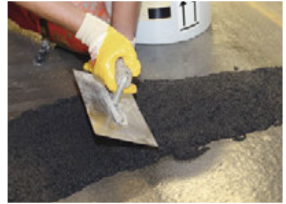
Reprofilieren Auffüllen von Fehlstellen z. B. mit Wecryl 242
