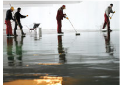
Aufbringen der wasserdichten Bodenbeschichtung mit Zahngummirakel und Stachelroller
