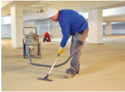
Untergrundvorbereitung z.B. Kugelstrahlen und Absaugen loser Bestandteile
