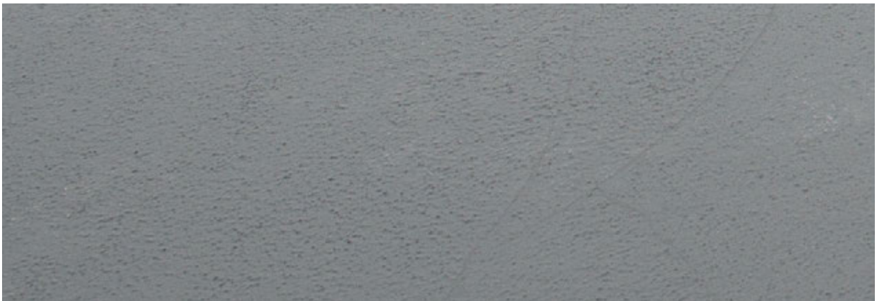
Strukturbelag mit Glättspachtel aufgebracht
