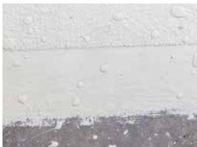
Hier ist der komplette Systemaufbau zu sehen – Untergrund, Wecryl R 230, Vlies und Wecryl R 230.
