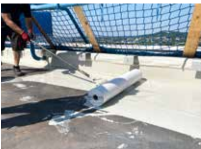
Auf der Dachfläche sorgte das Wecryl R 230 in Verbindung mit dem Vlies für eine nahtlose Abdichtung.
