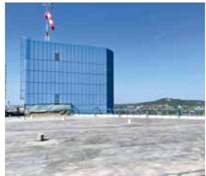
Nachdem die Fläche vollständig getrocknet war, wurde diese mithilfe des Weplus Reini-gers im Anschluss aktiviert.
