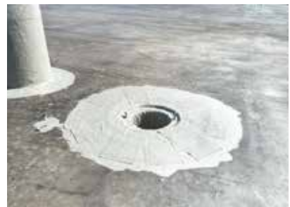
Ebenso wie bei den Aufkantung-en war auch das passgenaue Abdichten der Bodenabflüsse problemlos möglich.
