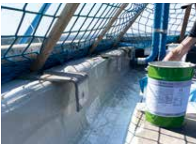
Auf Detailanschlüsse wie Aufkantung-en wurde der vliesarmierte Systemaufbau mit Wecryl R 230 thix aufgebracht.
