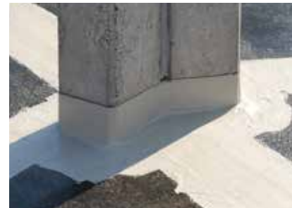
Mehr als 70 Anschlüsse wurden detailgenau nachmodelliert und erhielten eine nahtlose Abdichtung nach Maß.
