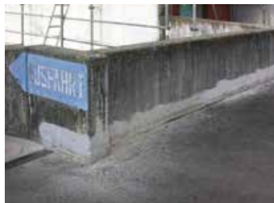
Diamantschleifen sämtlicher Details: unter anderem ca. 425 lfm. Wandanschlüsse, 15 Geländerpfosten, 31 Betonstützen und 18 Bodenabläufe.
