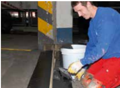
Der nach knapp einer Stunde überarbeitbare PMMA-Mörtel 242 kam auf Beton und Asphalt, wie hier zum Reprofilieren der Fugenflanken, zum Einsatz.
