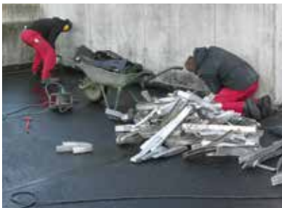
Die Maueranschluss-Schienen wurden samt altem Bitumenanschluss entfernt.
