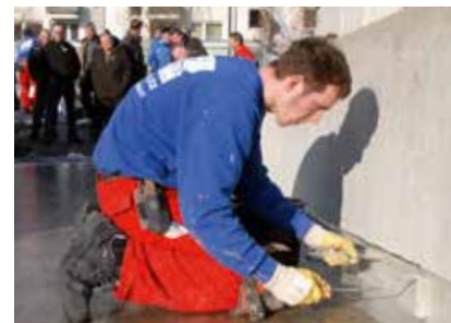
Beim Parkhaus-Event schauten Interessenten den Fachverlegern bei der Arbeit über die Schulter, wie hier z. B. beim Abdichten der Wandaufkantung.
