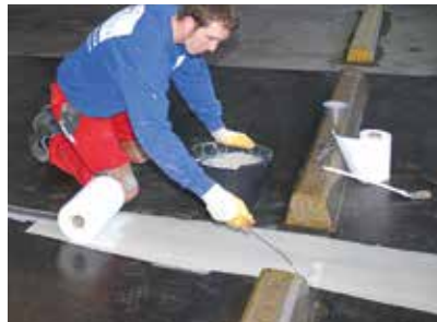
Flüssig abdichten in 3 Etappen: 1. PMMA-Harz Wecryl R 230 auftragen, 2. Vlies einarbeiten, 3. Nass-in-nass mit Harz sättigen.
