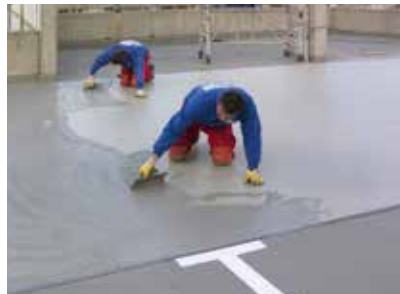
Auf eine Schutzebene aus Verlauffmörtel, die die Punktlasten verteilt, zogen die Fachverleger den mechanisch hoch beständigen Strukturbelag auf.
